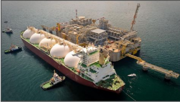
Adriatic LNG Terminal, Italy
