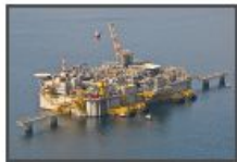
Adriatic LNG Terminal
