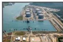
LNG Golden Pass Terminal
