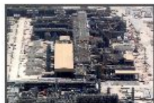
LNG RasGas Train 7
