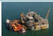
Adriatic LNG Terminal
